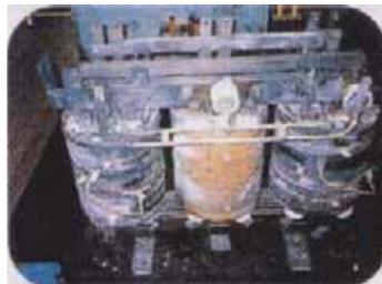
ガスケット劣化による油漏れ
