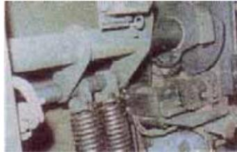
コンデンサ・セレンなどの劣化による電源出力低下 → 引き外し不良
